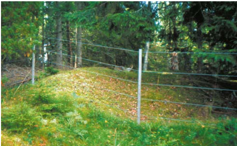
Bild 1. Noggrann uppsättning och material av god kvalitet är en förutsättning för ett bra elstängsel. Bilden visar ett stängsel av fabrikatet Insultimber med 2,5 mm tråd och eukalyptusstolpar. Denna stängseltyp kräver inga isolatorer.
